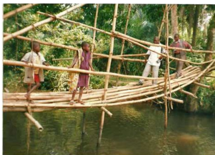
Pont dans le Walikale
